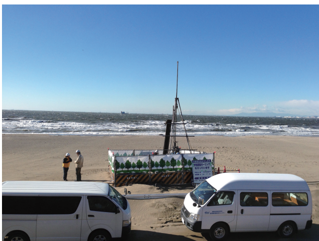
第1図 ボーリングの掘削風景。千葉マリンスタジアムの南側の砂浜。標高はTP 3.9 m、ボーリングの掘進長は40.3 m。この付近一帯は埋立地であり地表から深度10.75 mまでは人工地層からなる。沖積層の基底は深度37.55 mに確認された。
