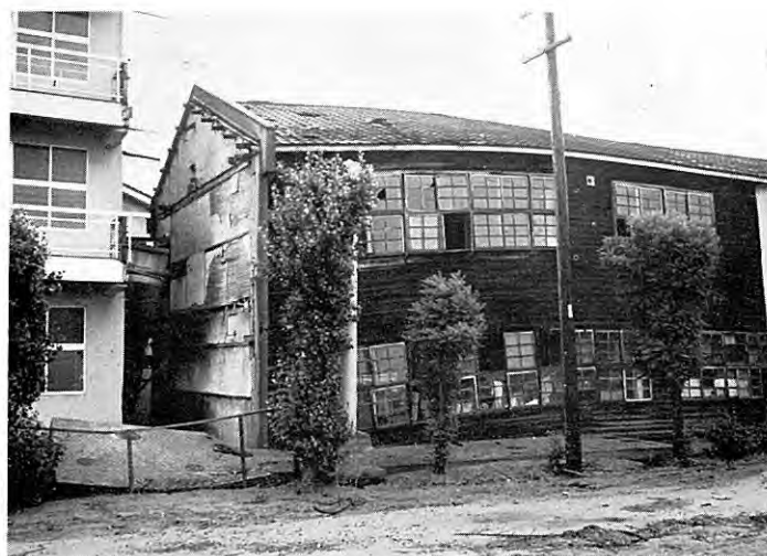
図版 9 不同沈下で扭曲した木造家屋 左下の下水槽が浮き上がっている。 (信濃川北西岸地域) (図版 14 参照)
