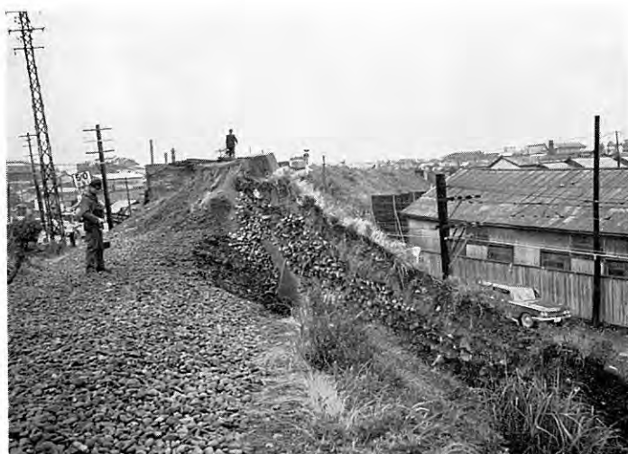
図版 10 越後線盛土路盤の地割れと崩壊路盤 2 m 以上下がっている。 (関屋・白山両駅のはほぼ中間、国道 18 号線陸橋の東側近く)
