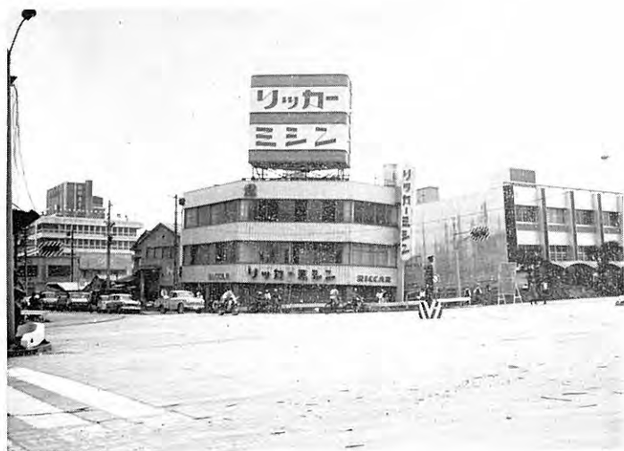
図版 26 駅前のビルディングの沈下傾倒
