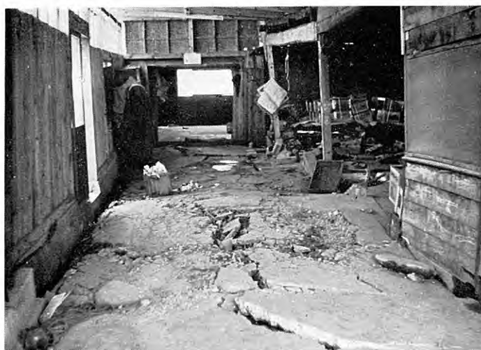
図版 72 村上市岩船市街の工場内の床上に生じた亀裂 (村上市災害対策本部提供)
