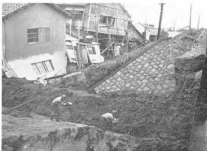
図版 12 図版 11 と同地点擁壁の傾倒と盛土ぞいの破壊された家屋
