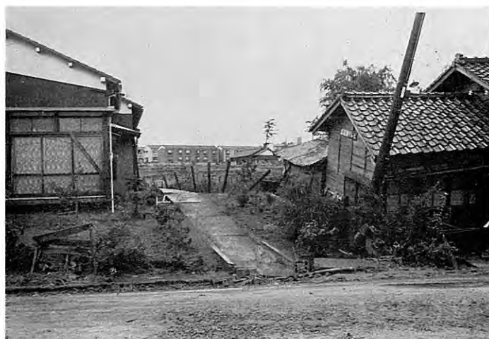
図版 37 砂丘縁辺部の押し出しを伴う波状うねり 左の家は地震前にくらべて約 2 m 上昇し、右の家は道路側に著しく傾いている。杭の列も上昇によって扇形に開いている。 (越後線寺尾駅の南東約 2 km)
