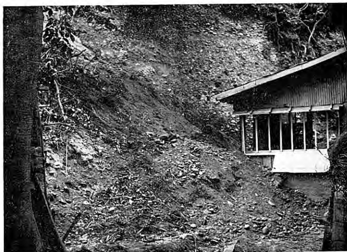
図版 70 村上市滝ノ前の崖崩れ (2) (村上市災害対策本部提供)
