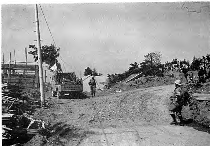
図版 34 図版 33 の溜まりの部分 中央にコンクリート道路（内野街道）の顕著な局部的隆起部がみられる。この隆起部の隆起量約 3 m。溜まりを切り開いて臨時の道路としている。（第 3 図参照）
