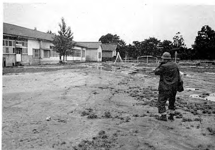
図版 84 新潟県北蒲原郡中条町 (1) 大田小学校校庭に生じた地割れ。 校庭の北西部は若干沈下して排水不良となり、調査当時 (39.6.22) 水溜りが生じていた。(鈴木泰輔撮影)
