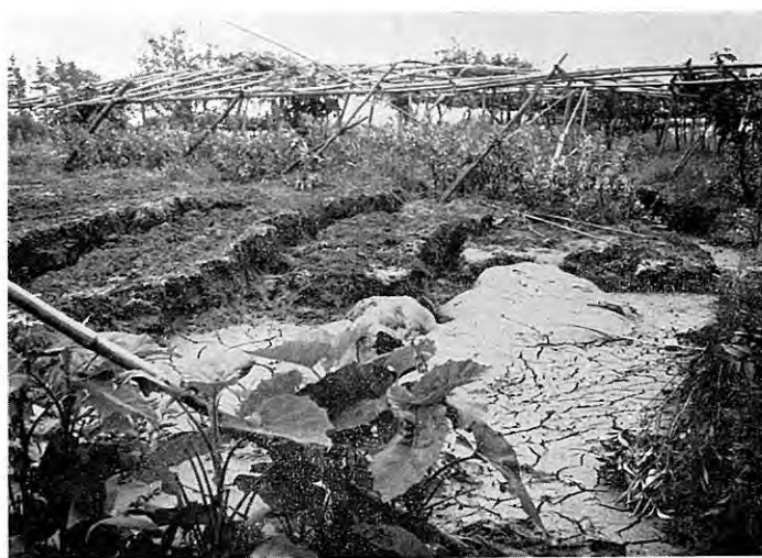
図版 39 黒崎村普久の畑中の地割れ群（ほぼN-S） 地割れは砂泥の噴出で埋められている。
