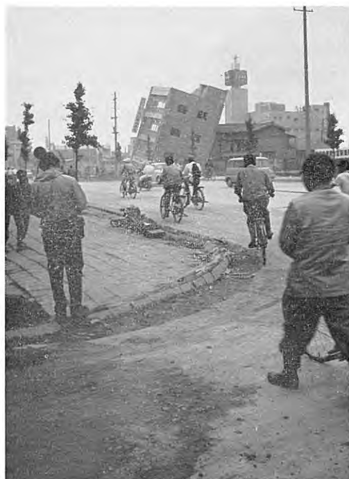
図版 28 駅前ビルディングの沈下傾倒（約18°） 歩道の縁の部分まくれ上がっている。
