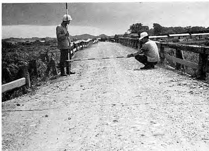
図版 68 村上市滝ノ前・瀬波間の橋梁（羽下ヶ滝橋）の破損（6月23日倒壊） （村上市災害対策本部提供）
