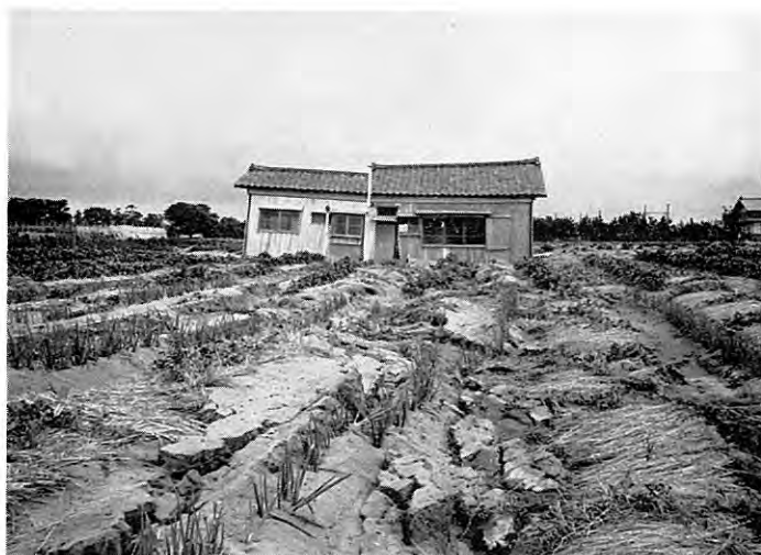
図版 41 地割れによって、ひきさかれた新築の木造家屋 噴砂を伴う地割れ群がほぼN-Sに走る。
