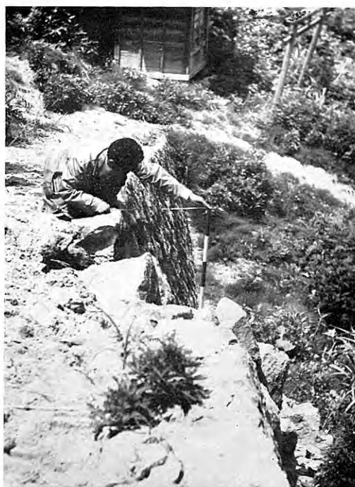
図版 55 鶴岡市湯野浜における石垣の水平ずれ (鶴岡市災害対策本部提供)
