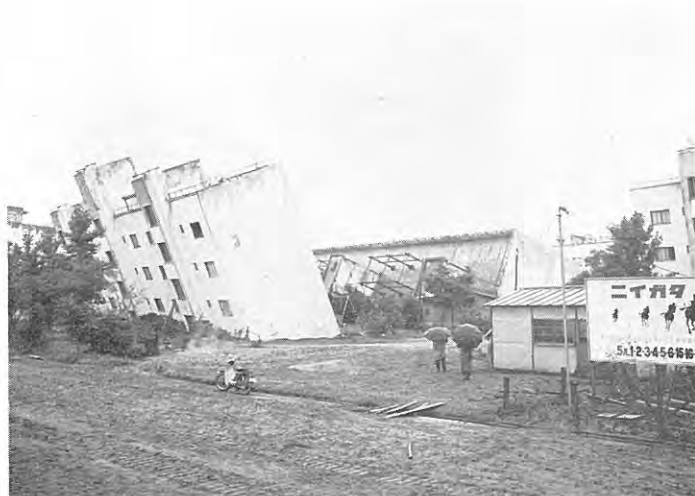
図版 6 傾倒した川岸町の県営アパート
