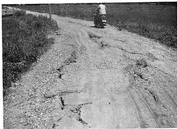
図版 67 村上市四日市・西興屋間における道路面の地割れ (村上市災害対策本部提供)
